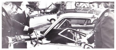
sprechfunkgeräte erweitert. Am 21. Juli 1981 erhielt die Feuerwehr zudem eine Rettungsschere und einen Spreizer mitsamt der dazugehörigen Öldruckpumpe, um bei Verkehrsunfällen innerhalb des gesamten Amtes Schuby eingeklemmte Personen retten zu können.
